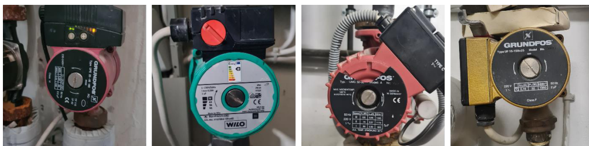
Abbildung 4-11: Veraltete Heizungspumpen
