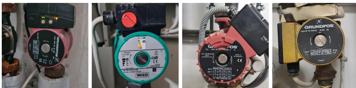
Abbildung 4-11: Veraltete Heizungspumpen
